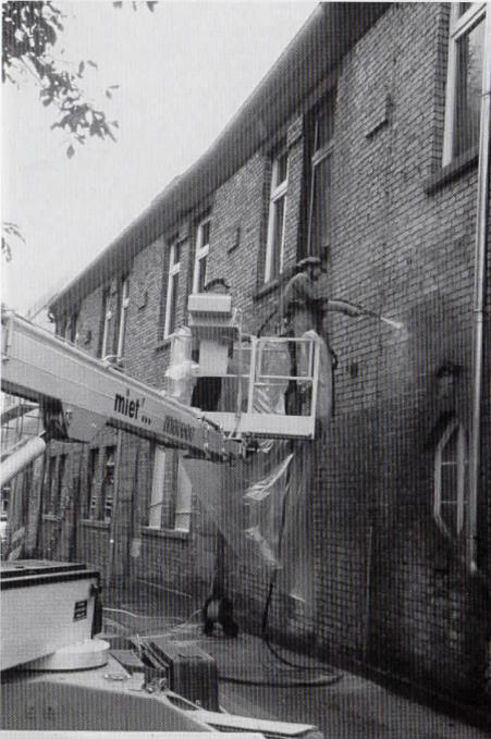
Der zur Karl-Abt-Straße hin über das Erdgeschoss auskragende Versorgungstrakt im Obergeschoss enthält die Toiletten, Küche und Garderobe sowie ein kleines Foyer für den Kettlersaal. Dieser neue Gebäudeteil ist der durch Sandstrahlen gereinigten Bestandsfassade farblich angepasst.
